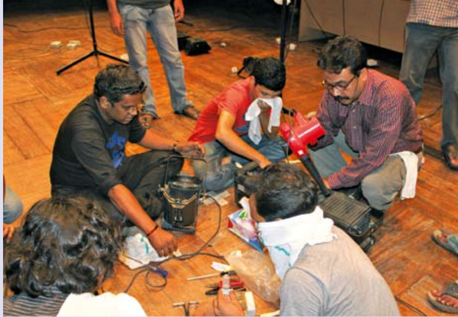
Die Scheinwerfer-Wartung zählt hier nicht zu den Lieblingsbeschäftigungen – der Staub vieler Jahre musste entfernt werden
